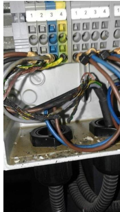
Рисунок – 22. Последствия неправильного подключения «массы» сварочного аппарата. Не использовать оборудование блока в качестве монтажных подмостей.
